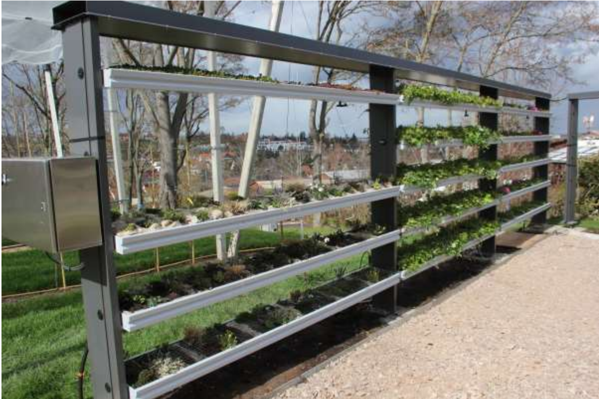
Abb. 1: CityLamwände 1 bis 3 zum Zeitpunkt der Installation (April 2021)
